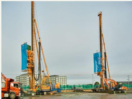
2024年2月20日 現場現況（敷地内からの写真）大型の重機（SAVEコンポーザー）を用いて地盤改良工事を行っています。
