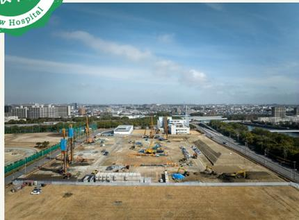
2024年2月20日 現場現況（新設小学校方面からの写真）2月初旬から静的締固め砂杭工法による砂杭地盤改良工事に着手しました。
