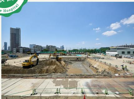
2024年6月19日 病院本体棟の掘削工事と、残土処分を行っています。6月下旬から固化工良による地盤改良工事に着手します。
