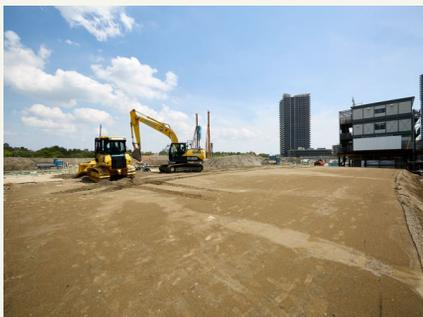
2024年6月19日 敷地内の盛土工事の様子です。現状地盤より1.5m程度の盛土を行い、施工地盤として整備しています。
