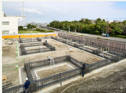
2024年10月21日 立体駐車場の基礎部分の躯体工事を進めています。
