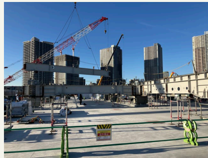
2024年12月25日 病院本体棟にて1階梁の鉄骨建方を開始しています。
