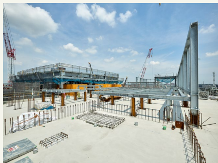
2025年8月18日 病院本体棟の屋上の作業風景です。
