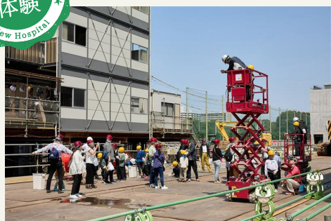
高所作業車に一人ずつ乗っていただきました。
